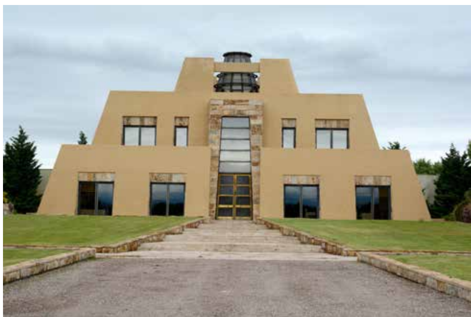
Catenas pyramidformade vinanläggning.
